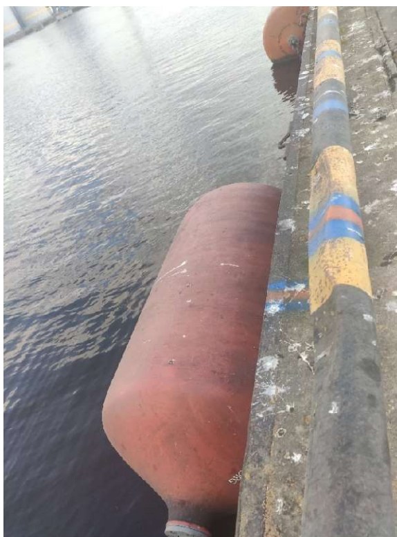
Att. 15 – Tērauda atvairbrusas lokālais mehāniskais bojājums
