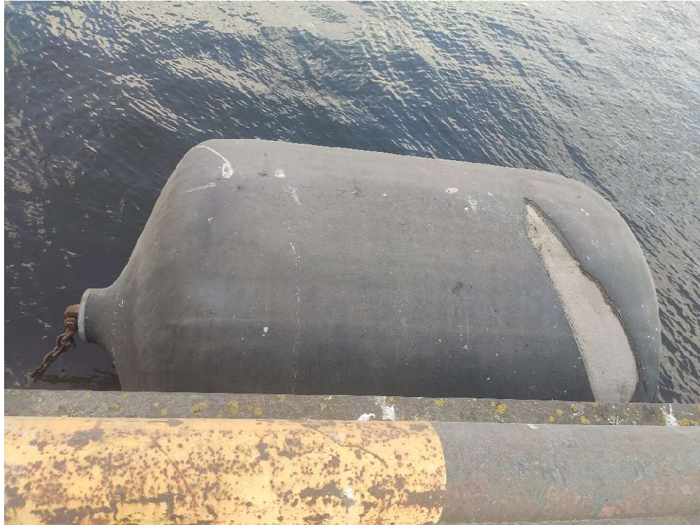
Att. 8 – Atvairierīce ar bojājumu aizsargkārtā
