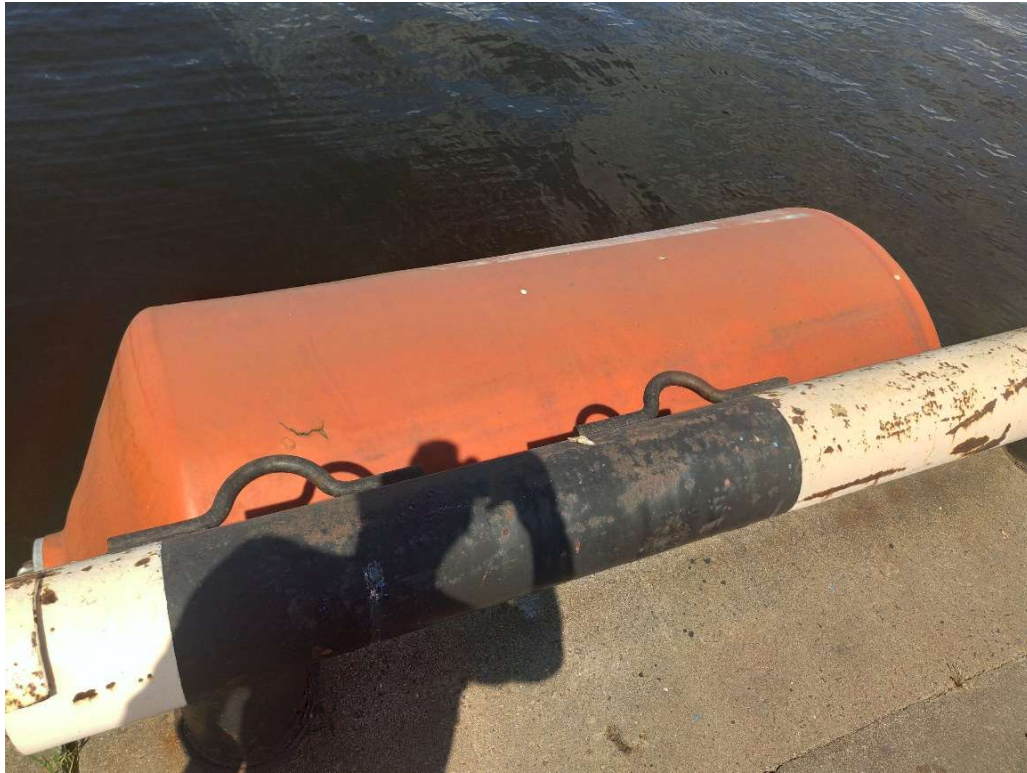
Att. 7 – Atvairierīce ar nelielu bojājumu aizsargkārtā
