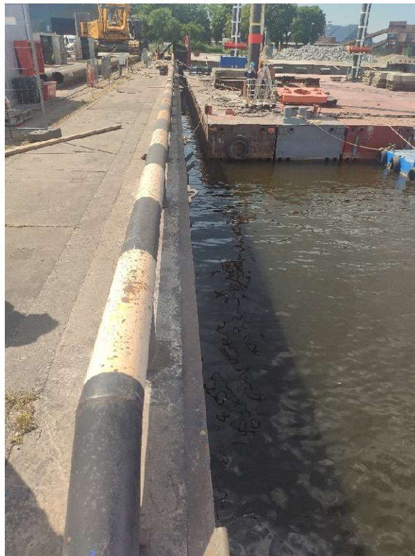
Att. 16 – Tērauda atvairbrusa (labā tehniskā stāvoklī)
