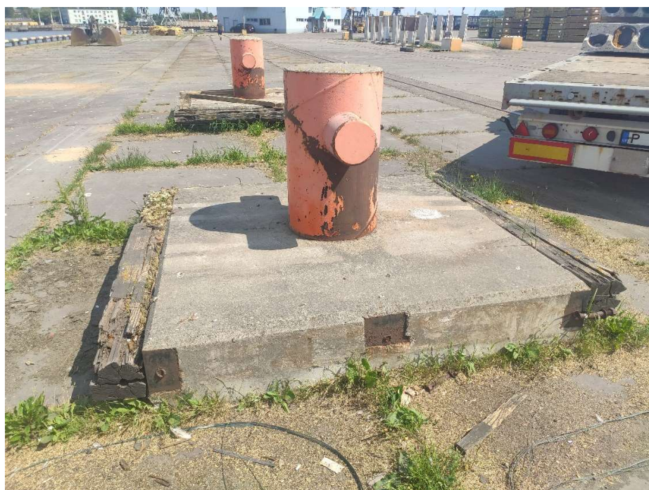
Att. 16 – Vētras poleru pamatnes mehāniskais bojājums
