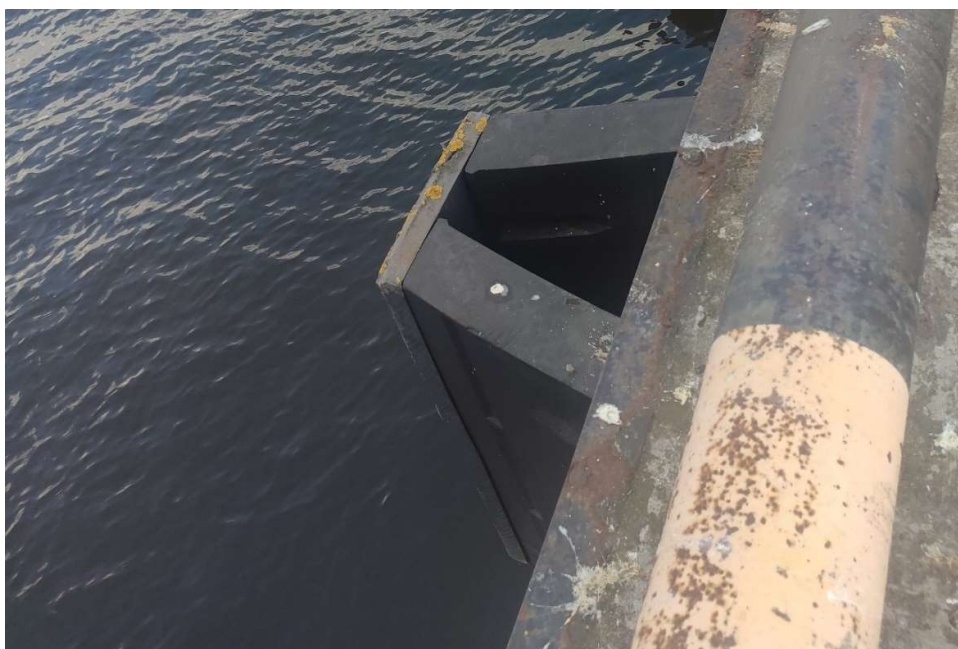
Att. 10 – Gumijas veida atvairierīce (vertikāli novietots)
